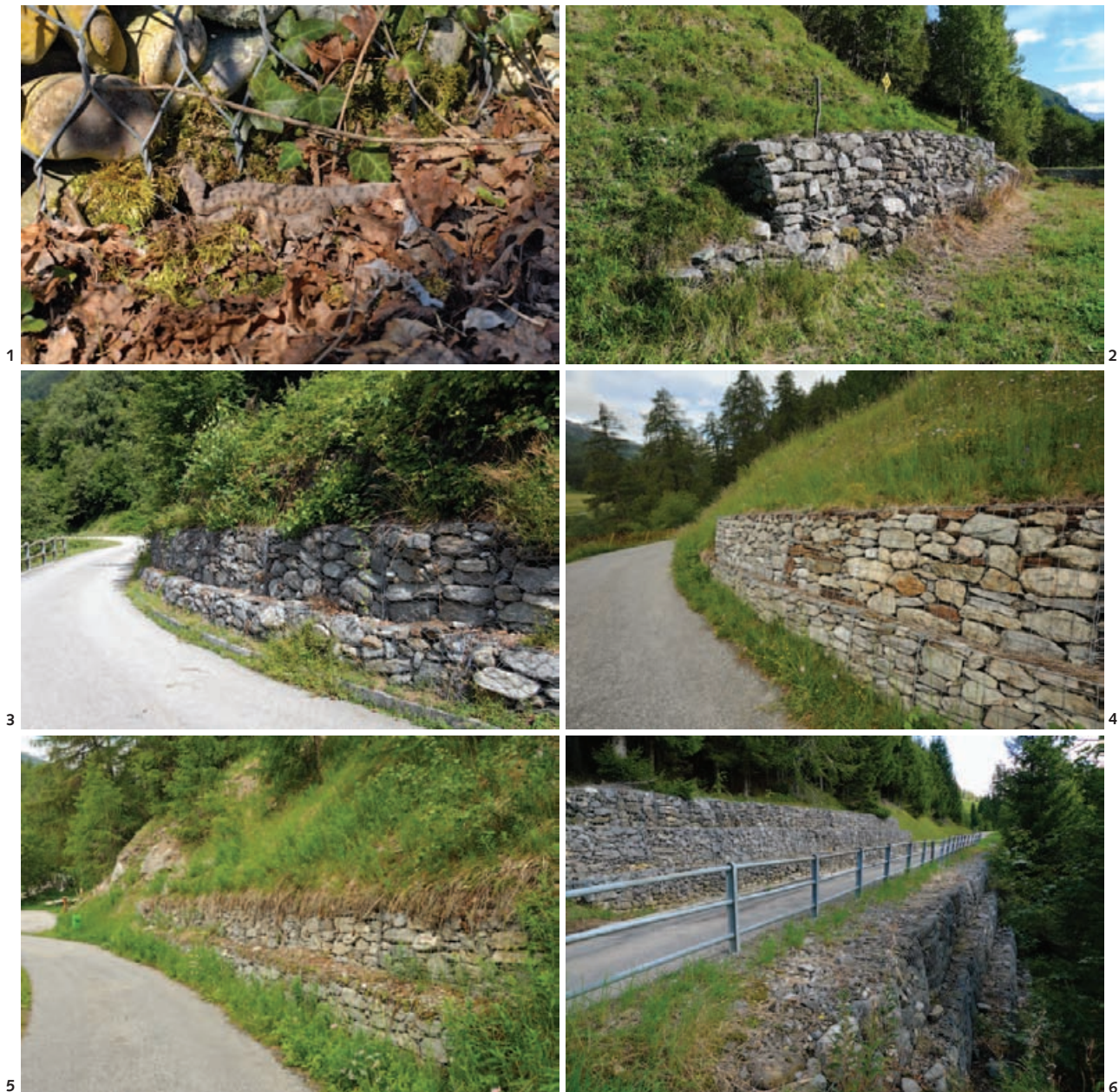
Fig. 1 Les gabions correctement construits offrent un habitat adéquat à presque tous les reptiles indigènes. Ici, une vipère aspic prenant le soleil au pied d'un gabion. Elle l'utilise également comme cachette et site d'hivernage. (AM)
