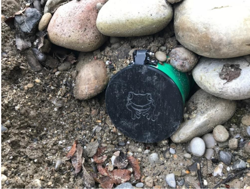
Fig. 10 : Conduite de drainage avec un clapet de protection des amphibiens à travers une nouvelle digue BLS à Ramsei. © Lukas Kohli, Hintermann+Weber AG
