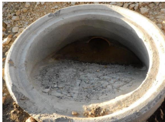
Fig. 9 : Plan incliné rugueux comme aide à la sortie.
