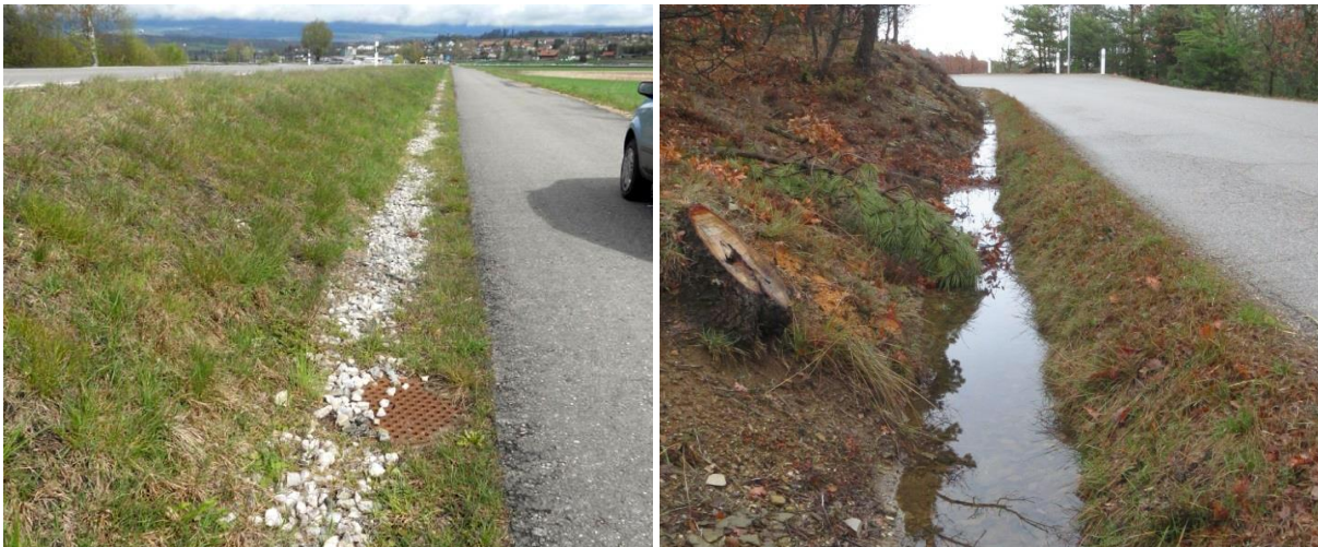
Abb. 1 + 2: Unterschiedlicher Umgang mit der Strassenentwässerung. Links: Sickerpackung mit Senkloch entlang einer Bewirtschaftungsstrasse. Rechts: Offen geführter Entwässerungsgraben einer Landstrasse. © Silvia Zumbach
