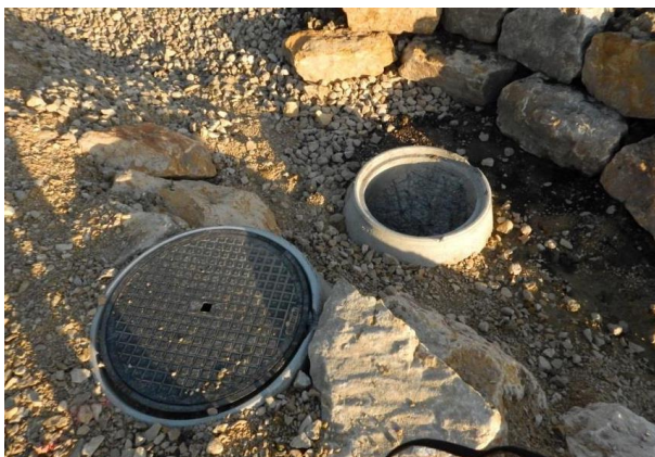
Abb. 8: Zweischachtsystem. Der Einlaufschacht wird nicht bodeneben, sondern erhöht eingebaut, damit Wasser im Graben stehen bleibt (rechts im Bild nach dem Bau, noch ohne Wasser). © Silvia Zumbach
