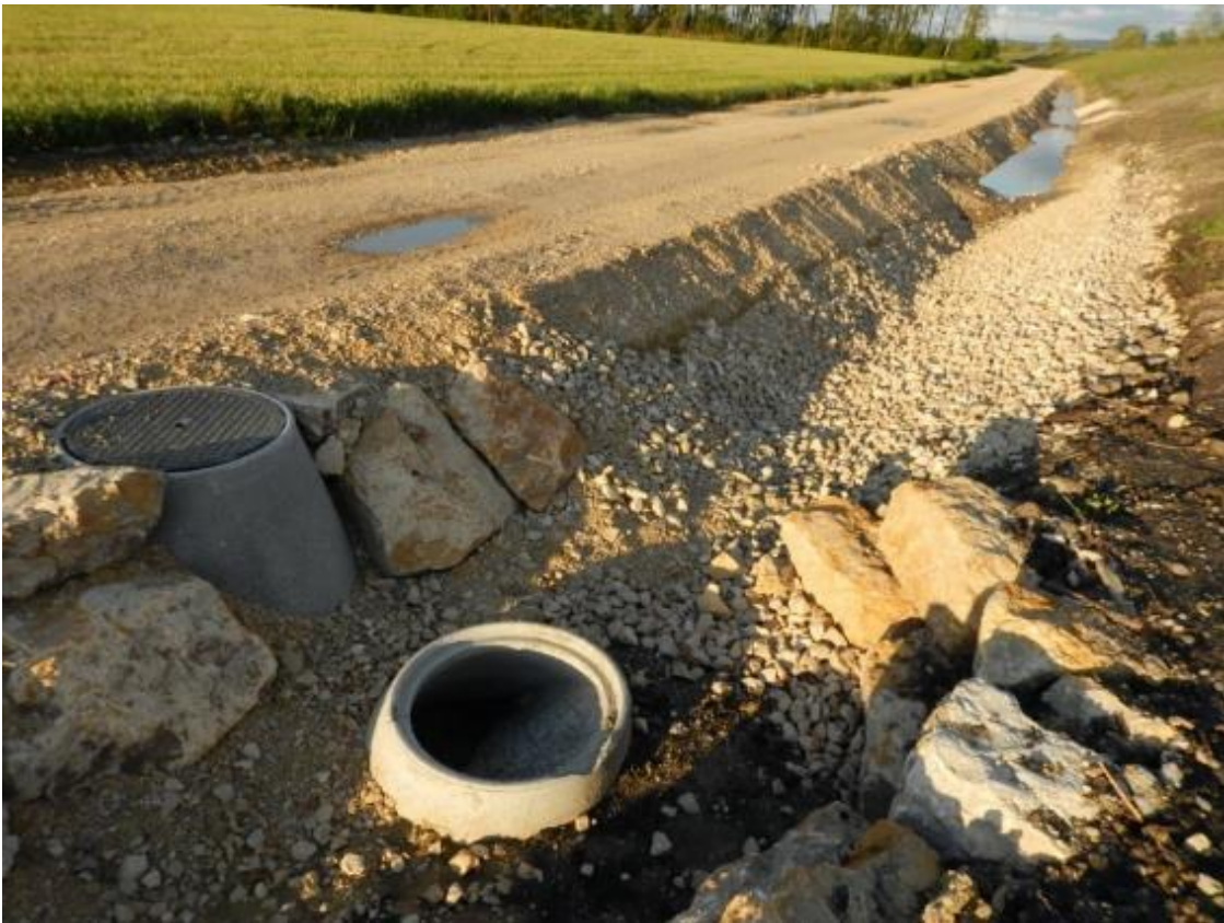
Abb. 5: Oberflächlich geführter Entwässerungsgraben mit einem Amphibienschonenden Einleitungsschacht entlang des Damms am Hagneckkanal. © Silvia Zumbach
