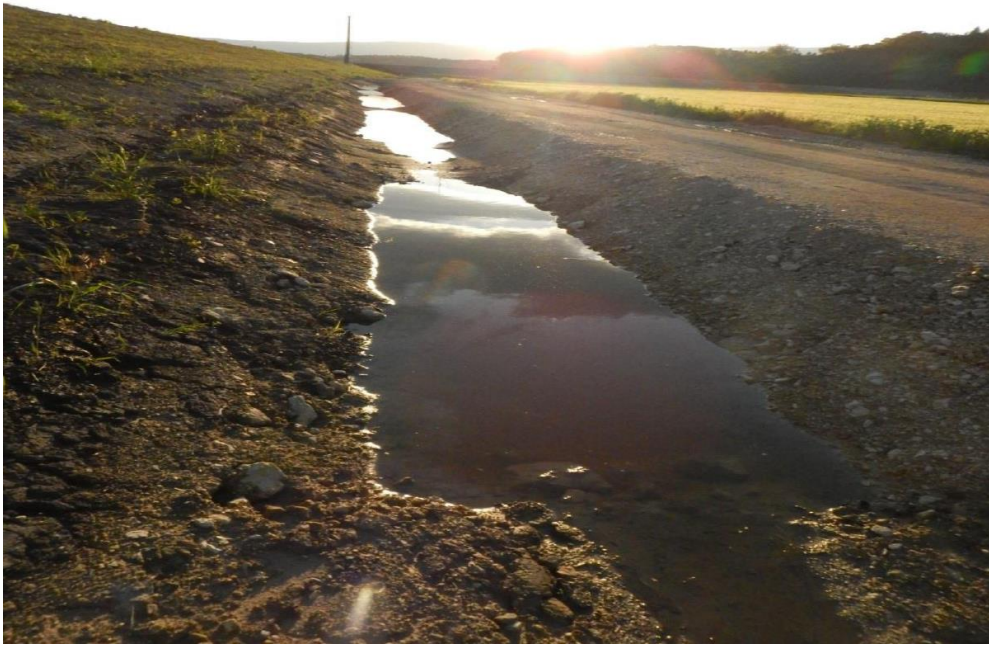
Abb. 3: Abschnittsweise unterteilter Wassergraben entlang des Hagneckkanals, Kt. Bern. Aufgrund des starken Sedimenteintrags müssen die Mulden bei den Unterhaltsarbeiten regelmässig wiederhergestellt werden. © Silvia Zumbach
