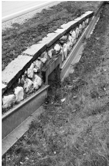
Abb. 1: Der Anschluss des Leitsystems an einen Durchlass ist der kritische Punkt vieler Schutzanlagen.
