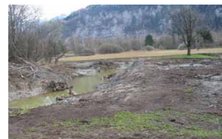
Wenn im Schwankungsbereich des Grundwassers bis zum Niedrigwasserstand gegraben wird, entstehen Gewässer, die sich im Frühling mit Wasser füllen und gegen Ende Sommer wieder austrocknen.
