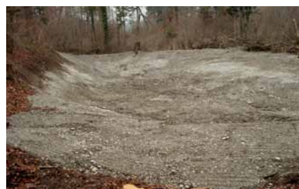
Wenn im Schwankungsbereich des Grundwassers bis zum Niedrigwasserstand gegraben wird, entstehen Gewässer, die sich im Frühling mit Wasser füllen und gegen Ende Sommer wieder austrocknen.
