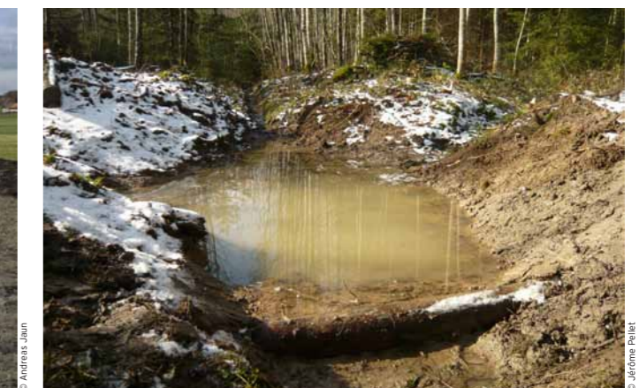
Illustration 1. Abgeschürfte Fläche in einer von Natur aus feuchten Senke und Stauvorrichtung in einem verbreiterten Waldgraben.
